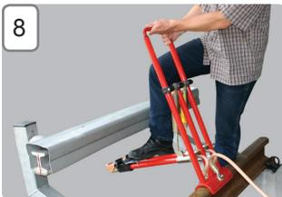
Danach können Sie den Kurzschließer von Fahr- und Stromschiene nehmen.
