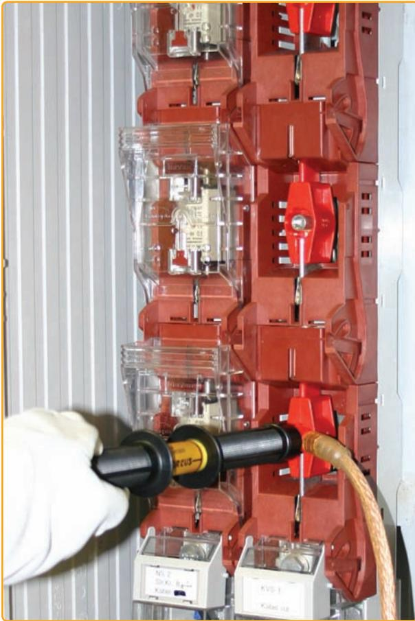
Steckmesser zum Einsetzen in Sicherungsunterteile
